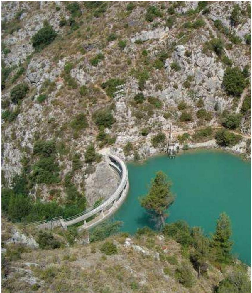
L'eau (acteur) exerce une action mécanique de contact répartie sur la paroi du barrage (receveur).
