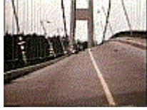
Soumis à des actions mécaniques, le tablier du pont ci-dessus se déforme.
